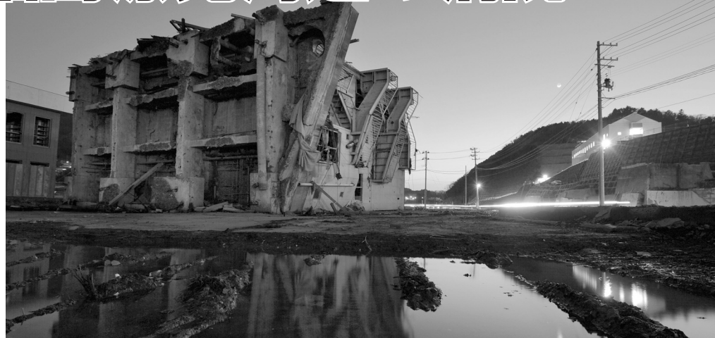
▲土台をみせて横たわる4階建ビル(宮城県女川町)。被災地には今も手つかずの倒壊家屋等が見られる。
